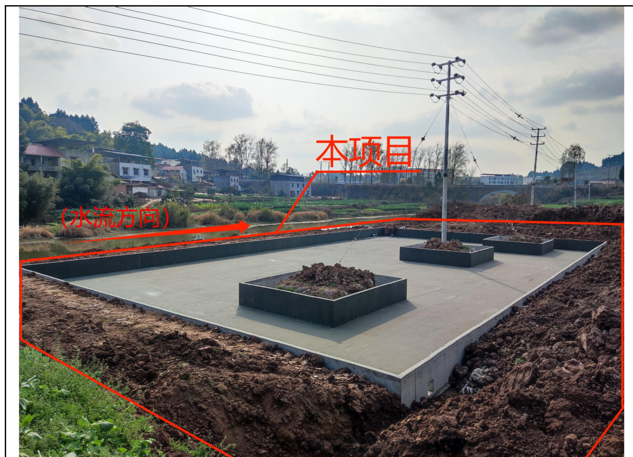
图 7 项目区地块现状（童家镇污水处理厂尾水治理区 2024.1.25）
