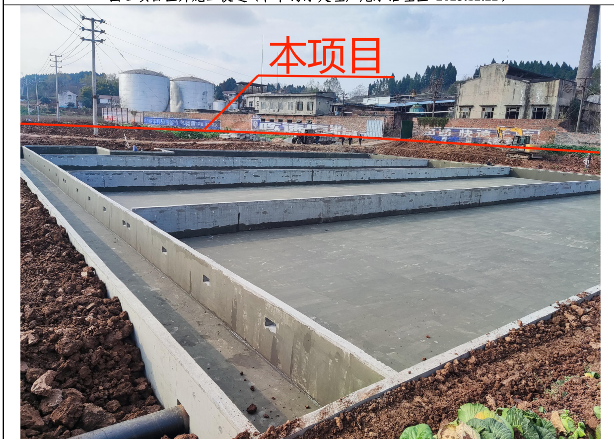
图 6 项目区地块现状（童家镇污水处理厂尾水治理区 2024.1.25）
