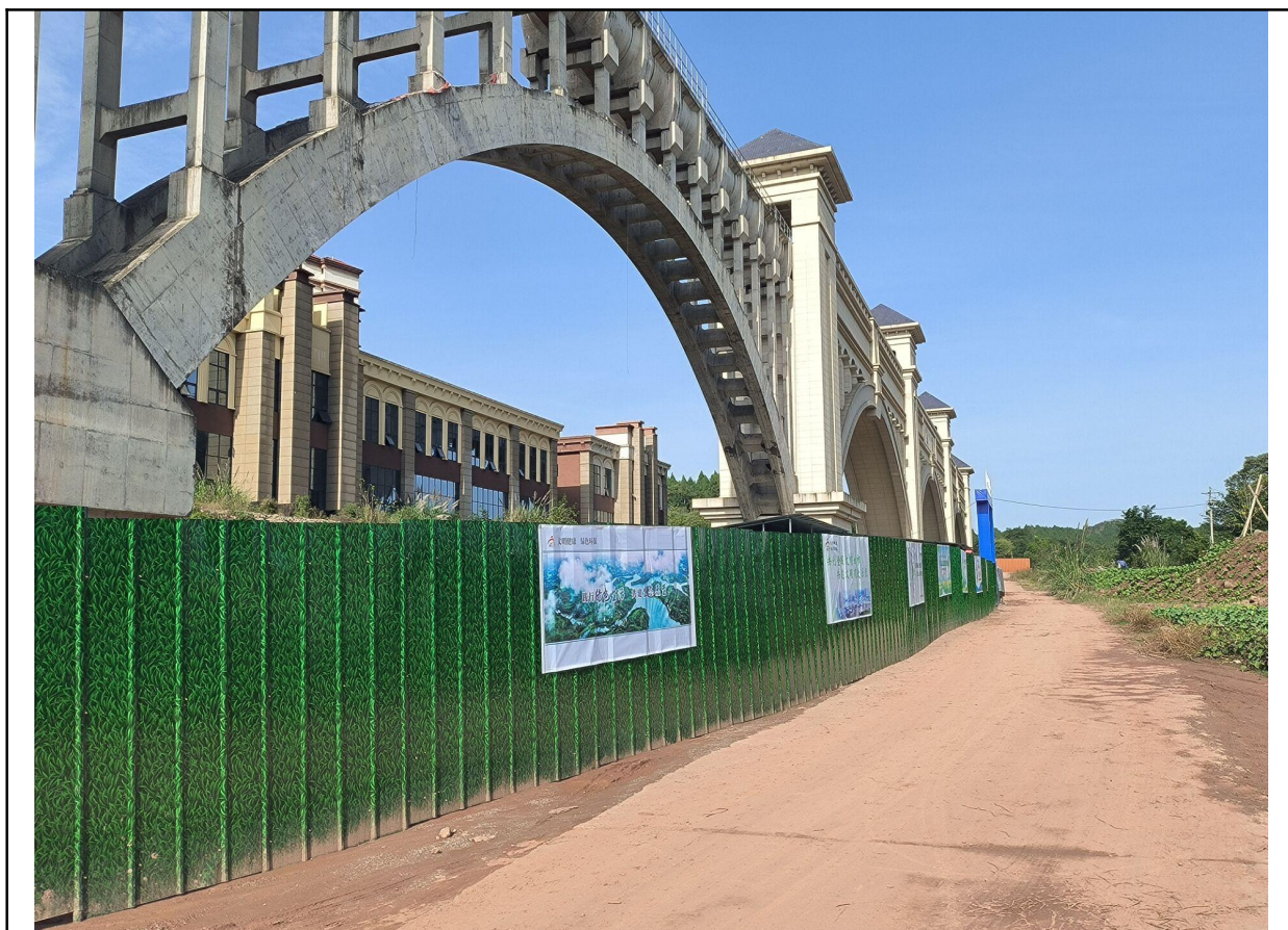
图 5 项目区外施工便道（仁和污水处理厂尾水治理区 2023.12.22）
